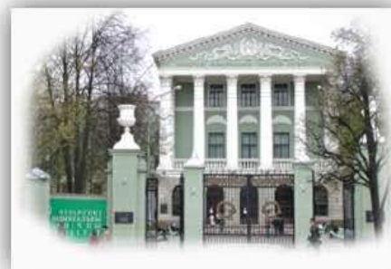
Военно-технический факультет в БНТУ
