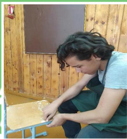
К деревянному каркасу крышку целесообразно дополнительно прикрепить сверху «на проход» двумя-четырьмя шурупами 5x50. Шурупы следует закручивать так, чтобы их головки прорикли на 1-2 мм ниже плоскости крышки.
