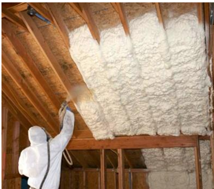
Рис. 21. Напыление пенополиуретана
