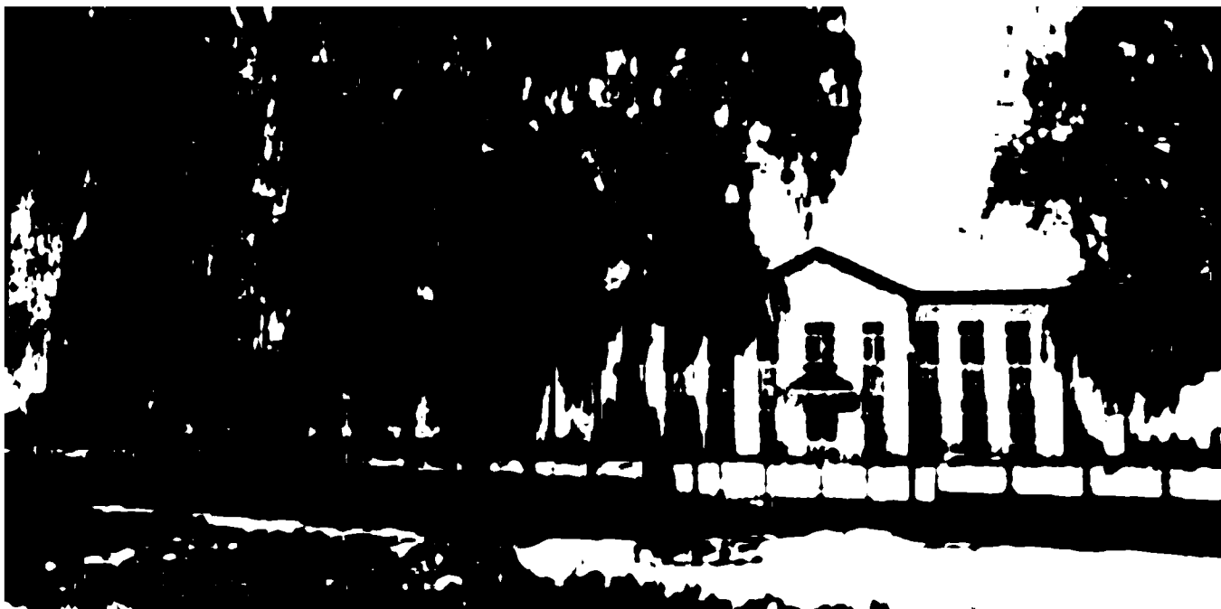
Рис.2 Вид существующего здания школы
