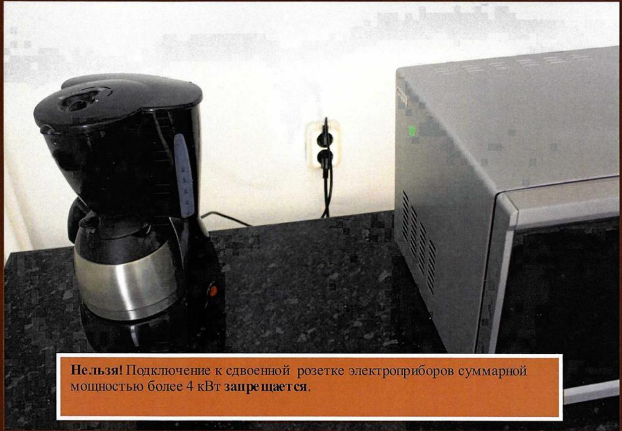
**Нельзя!** Подключение к сдвоенной розетке электроприборов суммарной мощностью более 4 кВт запрещается.
