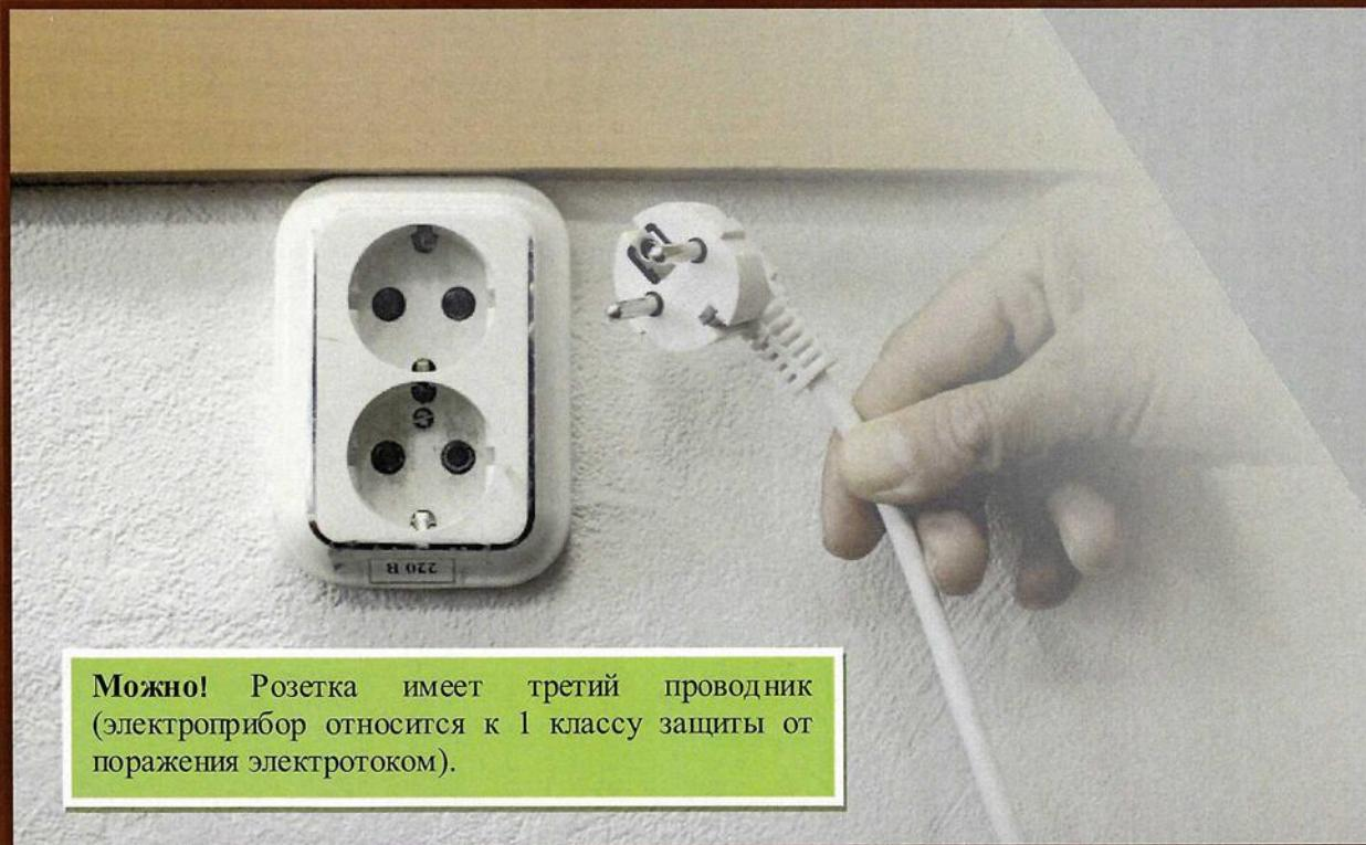
**Можно!** Розетка имеет третий проводник (электроприбор относится к 1 классу защиты от поражения электротоком).
