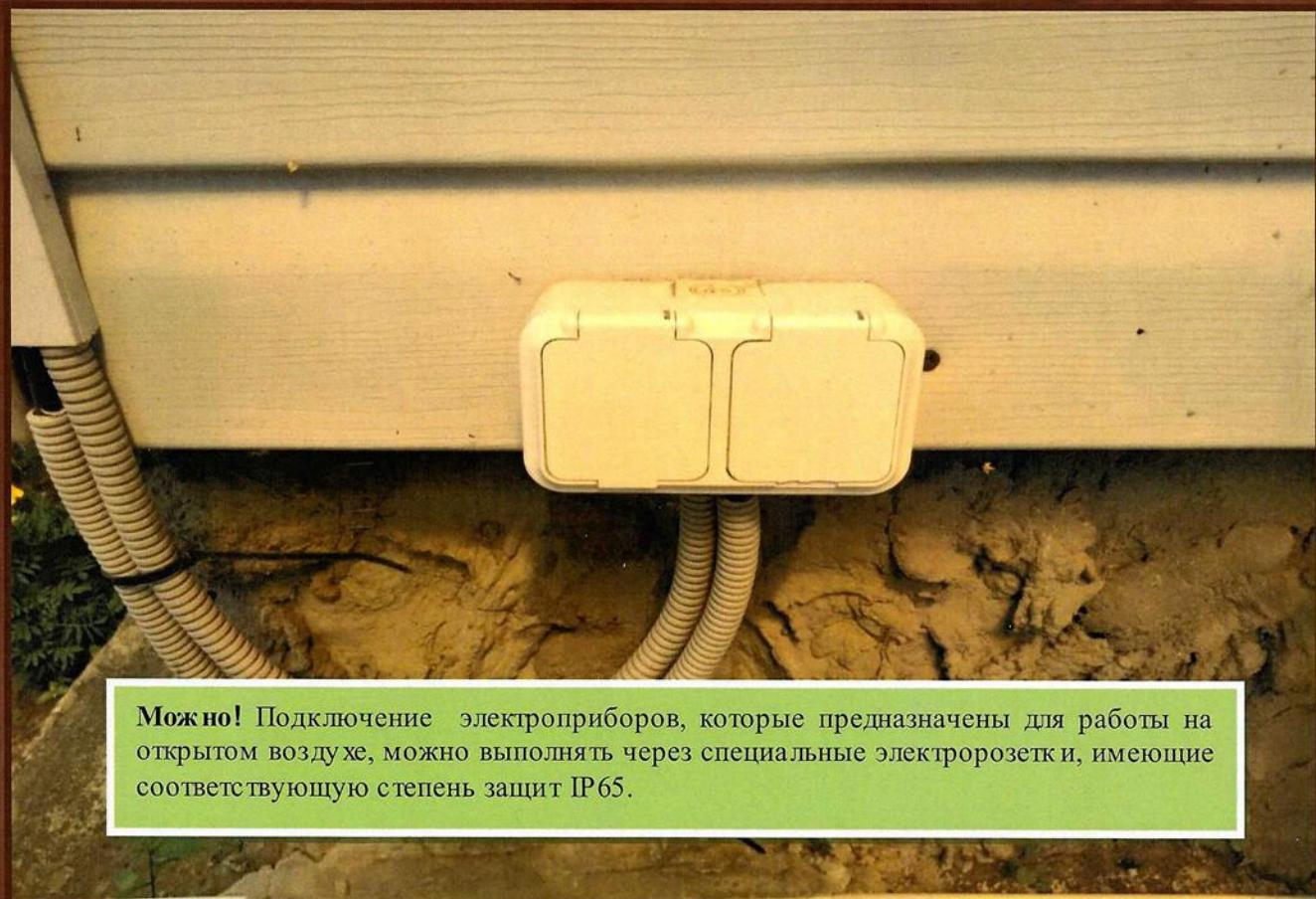
**Можно!** Подключение электроприборов, которые предназначены для работы на открытом воздухе, можно выполнять через специальные электророзетки, имеющие соответствующую степень защит IP65.
