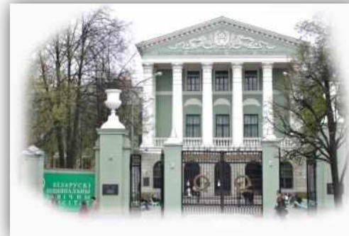
Военно-технический факультет в БНТУ
