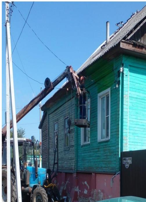
*Выполнение отделочных работ без применения средств индивидуальной защиты, в том числе предохранительных поясов.*
