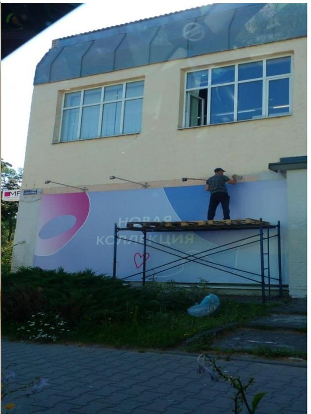
*Выполнение окрасочных работ с применением подмостей высотой 1,3 м и более без перильного и бортового ограждений, без применения средств индивидуальной защиты*
