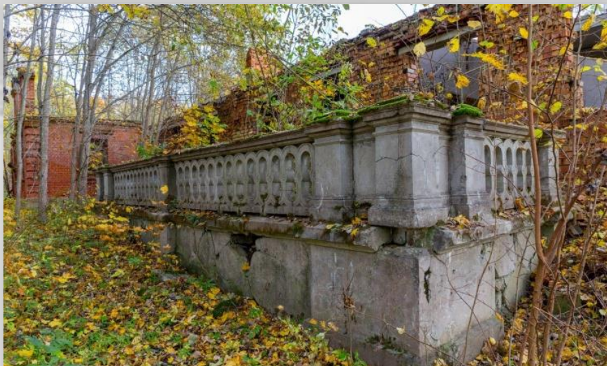
Здание усадебного комплекса в д. Ольшево
