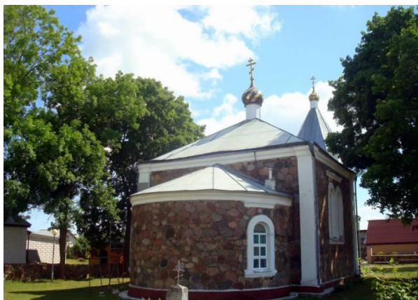
Фото 1. Ильинская церковь в аг. Нарочь
