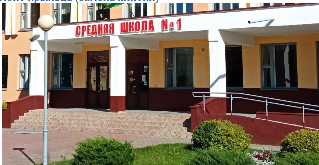
Ремонт крыльца (замена плитки)
