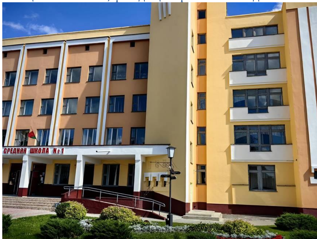
Покраска цоколя школы, фасада центрального входа
