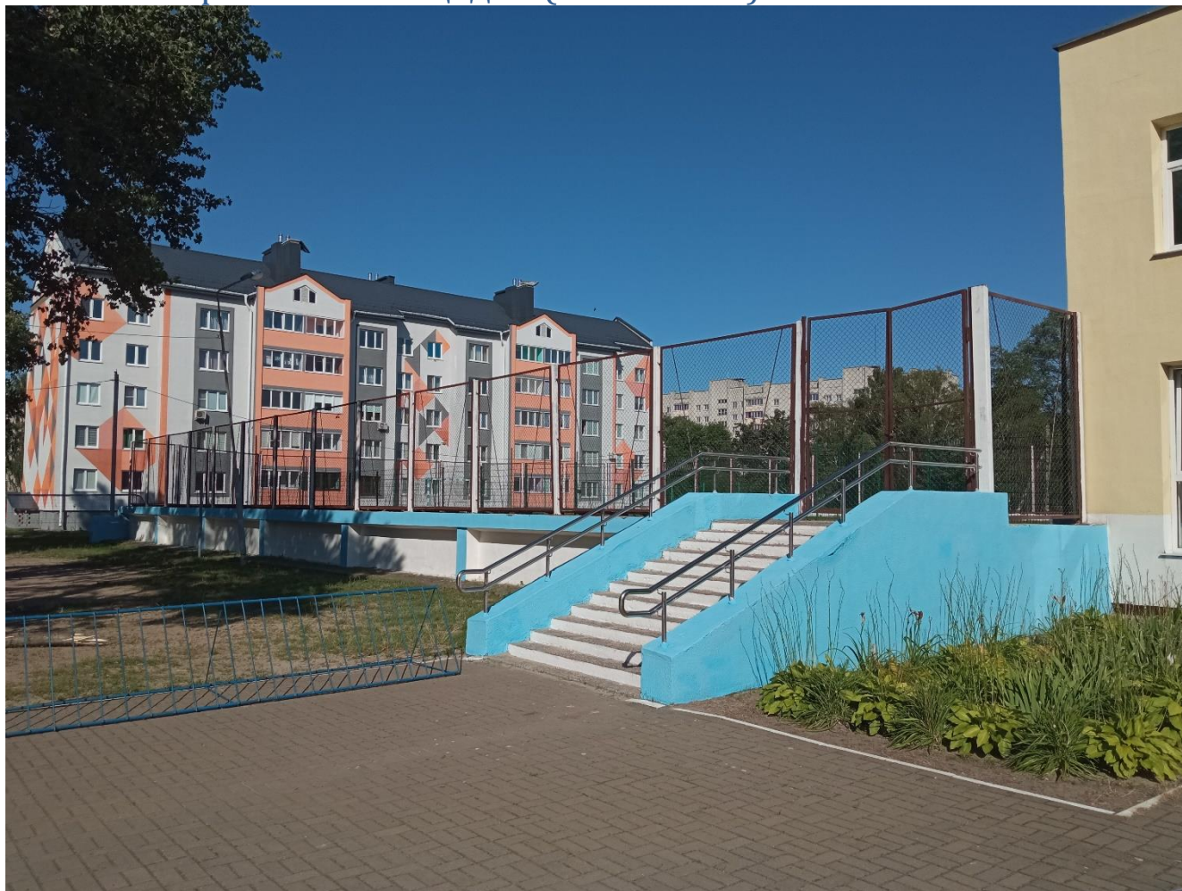
Ремонт спортивной площадки (мини-поля)
