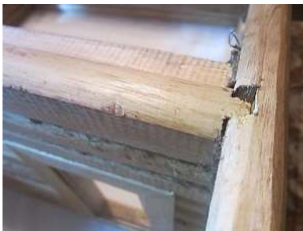
Рис. 8. Соединение «в сковородень»
