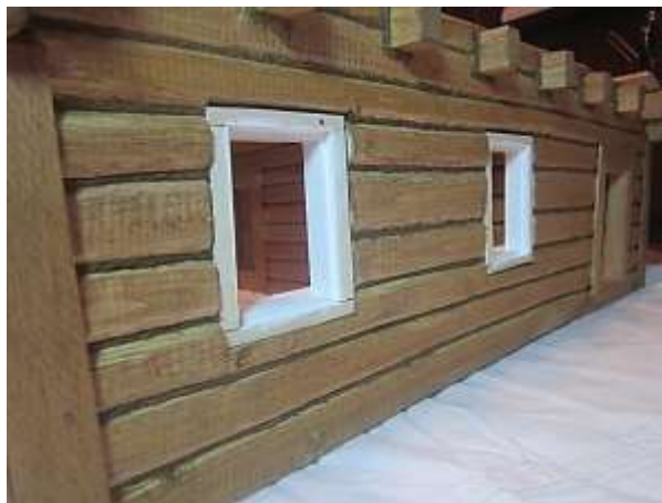
Рис. 17. Установка оконных коробок
