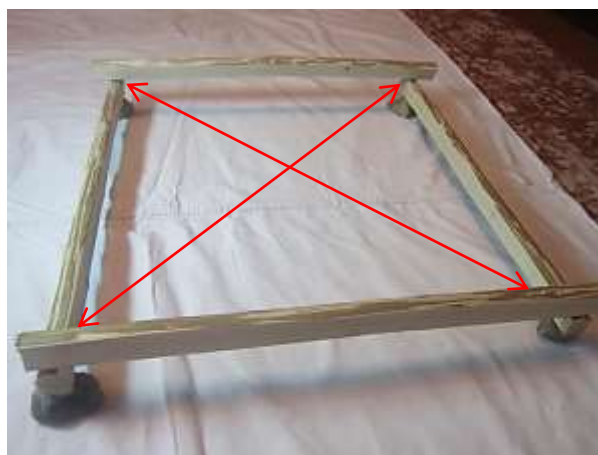
Рис. 3. Устройство окладного венца
