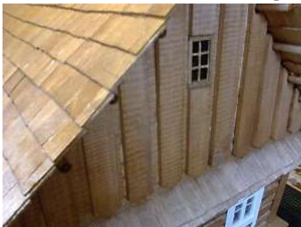
Рис. 16. Устройство фронтонов
