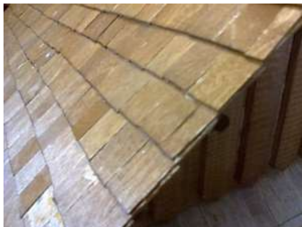
Рис. 15. Устройство покрытия из драни
