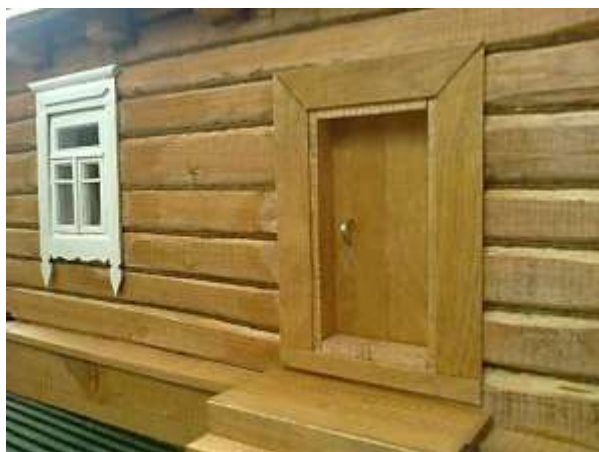
Рис. 19. Устройство дверного проема
