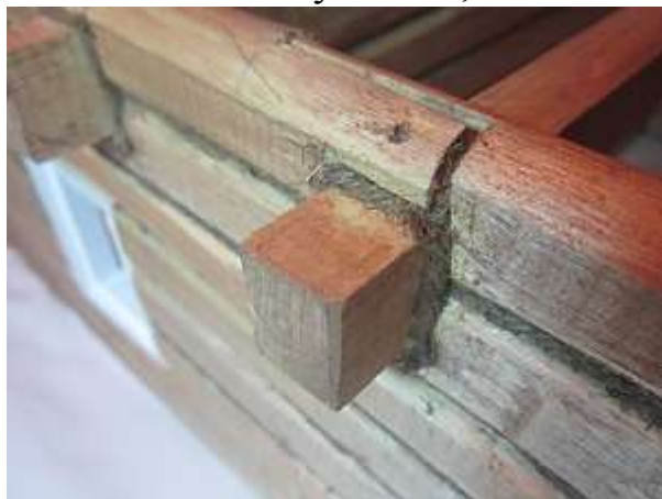
Рис. 7. Соединение бревен по длине
