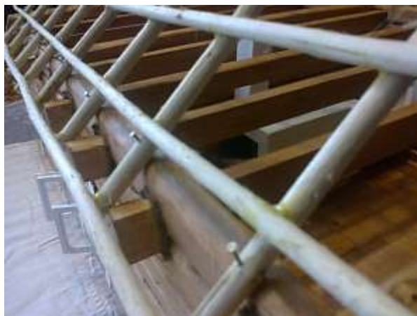
Рис. 12. Опора стропил на мауэрлат
